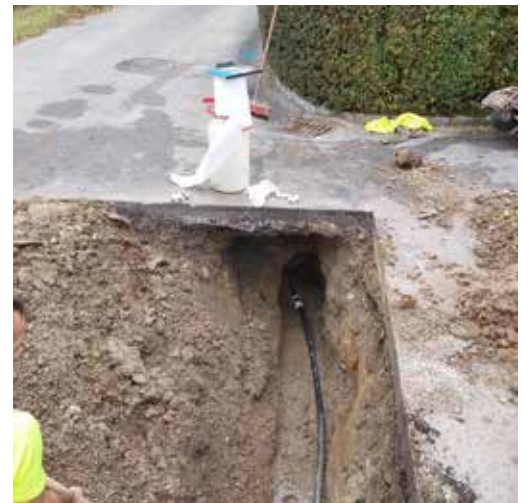
Bruch eines Trinkwasserrohrs infolge einer Unterspülung
