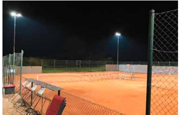
Die neue Flutlichtanlage am Tennisplatz Schollach.
